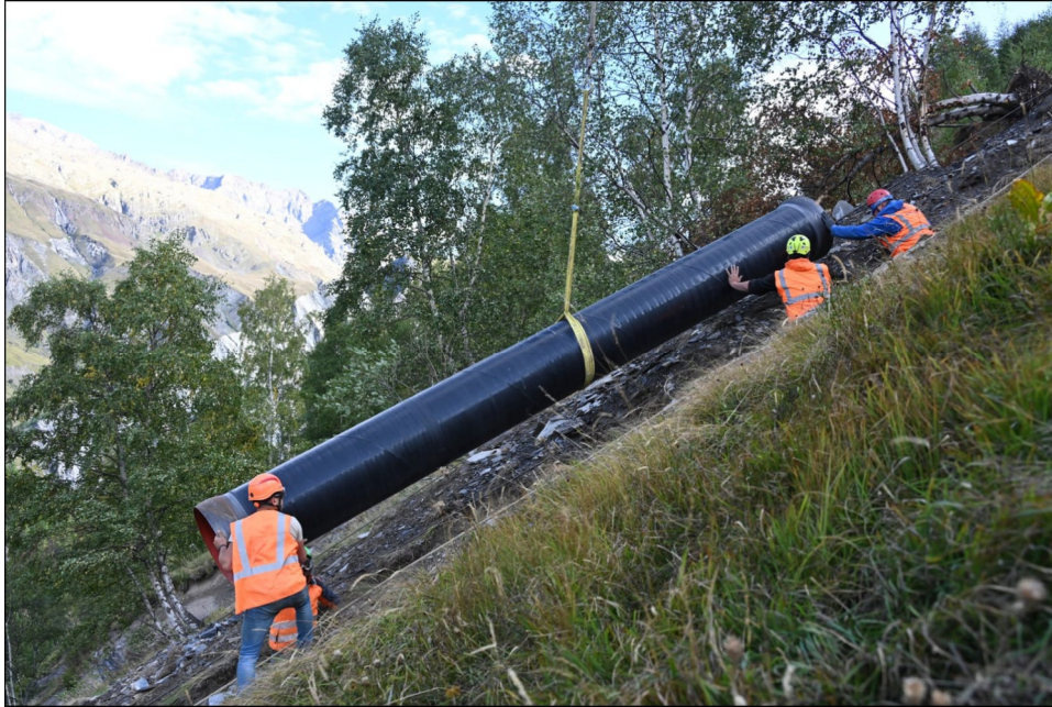
Figure 2 - Pose d'une conduite forcée – Chantier de la Valette (SERHY)
