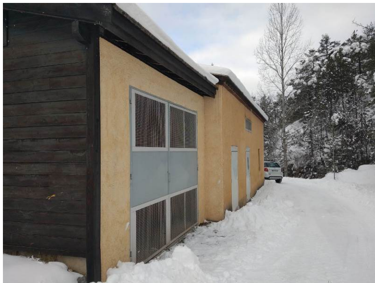
Figure 2 : Façade nord de l'usine
