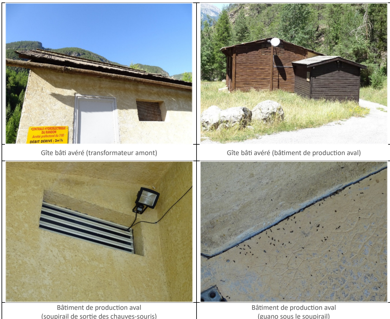
Figure 48 : Gîte bâti fonctionnel (centrale existante)
