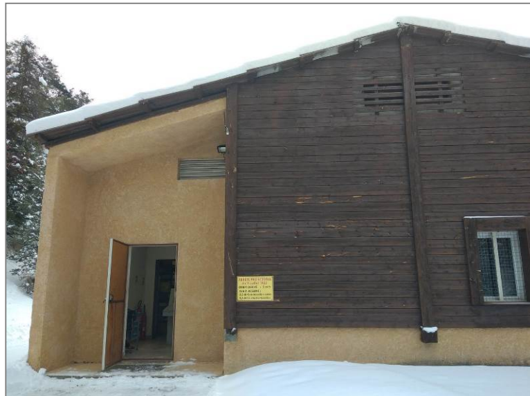
Figure 4 : Façade ouest de l'usine
