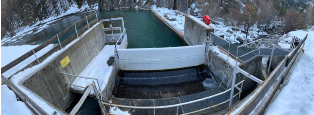
Figure 4 : Vue de la prise d'eau et de la grille d'entonnement actuelle
