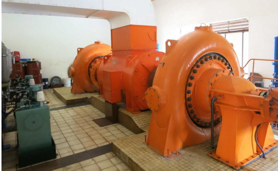
Figure 68 - Groupe turbo alternateur bi-roue Francis de la centrale
