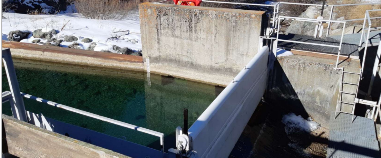
Figure 8 - Vue de la prise d'eau du Randon
