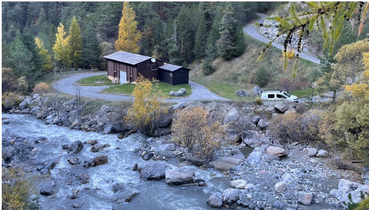
Figure 51 - Vue de l'enrochement existant de l'usine
