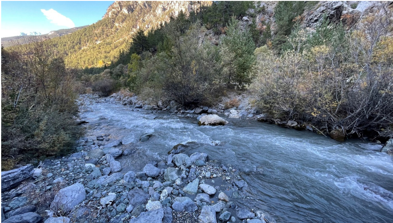
Figure 35 - Enrochement existant de la passerelle de Terre Rouge, de 1000 à 1100 m
