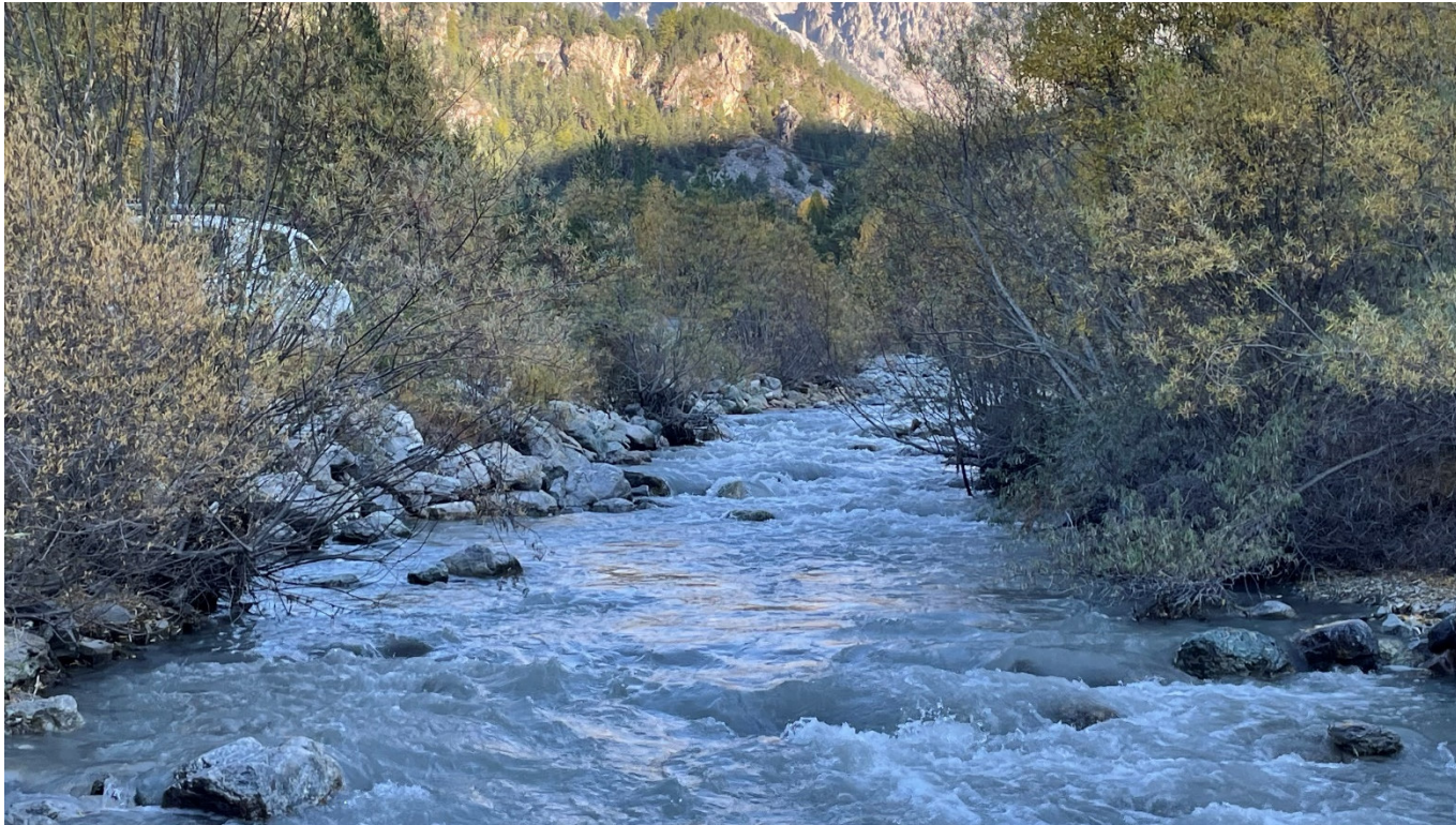
Figure 40 - Enrochement existant de la berge de la cote 1825 à 1935 m
