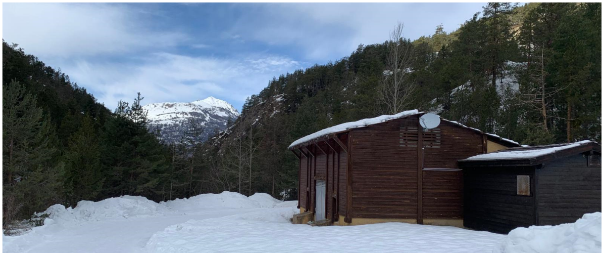
Figure 53 - Bâtiment de l'usine
