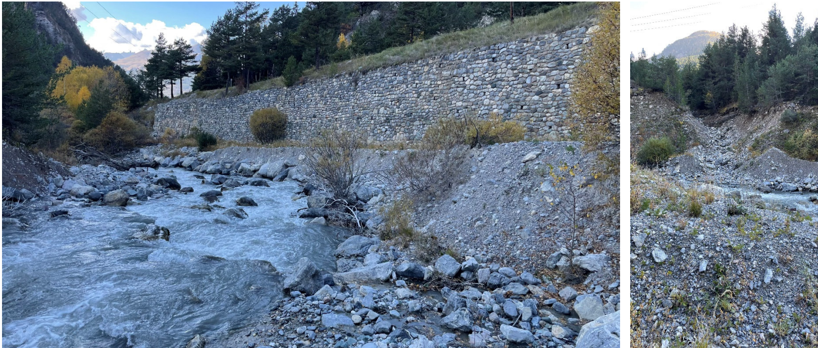
Figure 44 - Enrochement existant sous le mur de soutènement de la RD902 entre 2700 et 2800 m. À droite, cône du torrent des Rouilles
