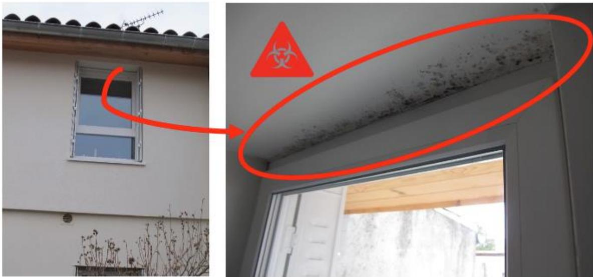
**Figure 35** : Moisissures apparues sur un pont thermique dû à la discontinuité de l'ITE et de l'isolation des combles (Source : Dorémi).
