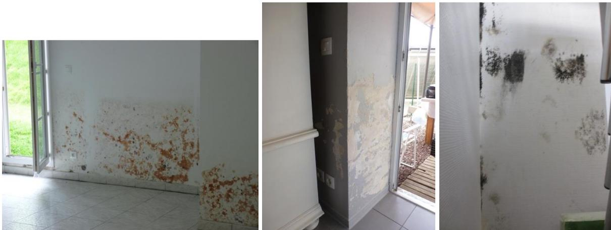
**Figure 6** : Apparition de moisissures à la suite de l'isolation de vieux murs. De gauche à droite : moisissures sur mur extérieur, humidité dans les murs par suite de l'installation d'un voile étanche sous le plancher, traces de moisissures dans un mur de refend (sources : AQC).
