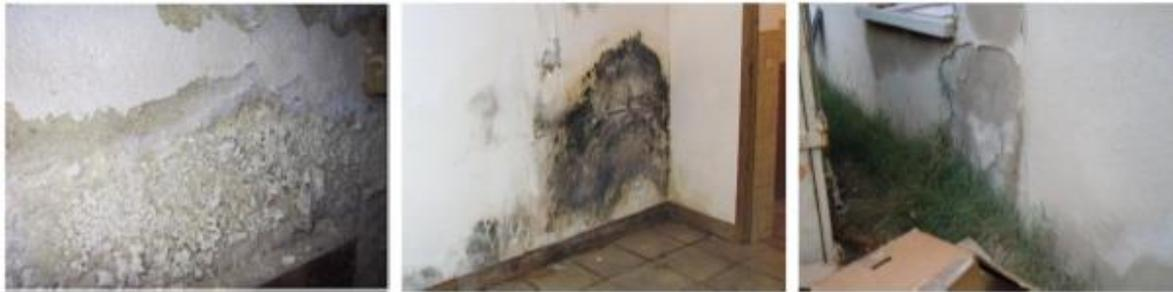
**Figure 5** : Pathologies observées après rénovation. De gauche à droite : présence de salpêtre (source : humidites.fr), présence de moisissures sur mur intérieur (source : prix-immobilier.info), trace d'humidité et enduit extérieur dégradé (source : Enertech).
