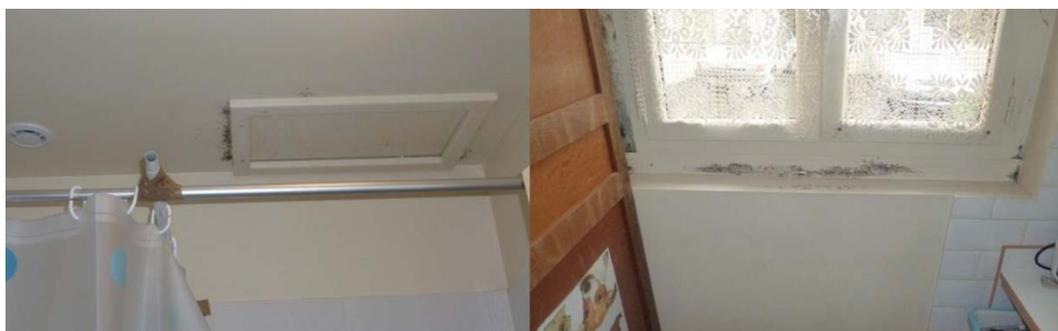
**Figure 9 :** Exemple de développement de moisissures autour d'une trappe de la salle de bain ainsi qu'en périphérie de la menuiserie extérieure de la cuisine, moins d'un an après rénovation thermique d'un logement avec absence de ventilation (à l'arrêt). Source PUCA (**PUCA, janvier 2013**).
