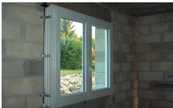
Figure 15 : Fenêtre posée en applique en attente d'une ITI
