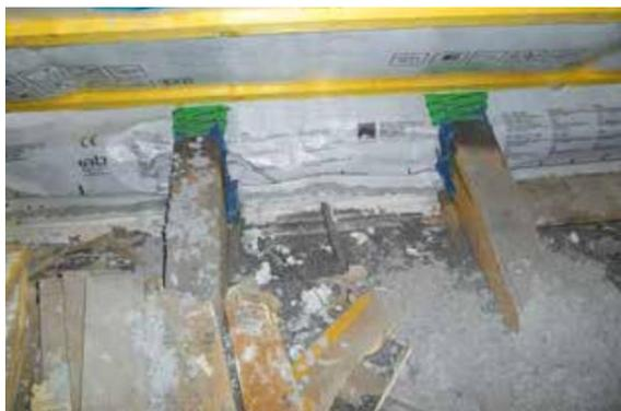
**Figure 7** : Phénomène de condensation au niveau des têtes de solives, renforcé par l'absence de ventilation en phase chantier (cas pouvant se produire également dans un logement rénové peu ou non ventilé). Source : AQC (**AQC, Humidité dans la construction, 2019**).
