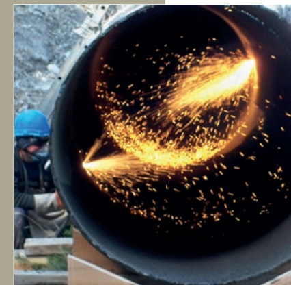
▲ Dépose de l'ancienne conduite d'amenée ◀ Barrage de Pont Baldy, vidange 2011 ▶ Centrale de Pont Baldy, la turbine
